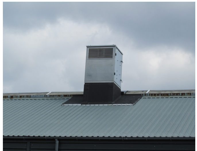
Dachaggregat RT-3000T mit Lüftungsgitter VR
